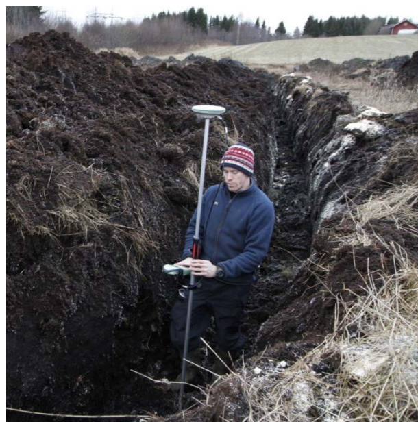
Figur 17 - Logging av åpne grøfter. Brukt med tilatelse. Foto Ola Tande
