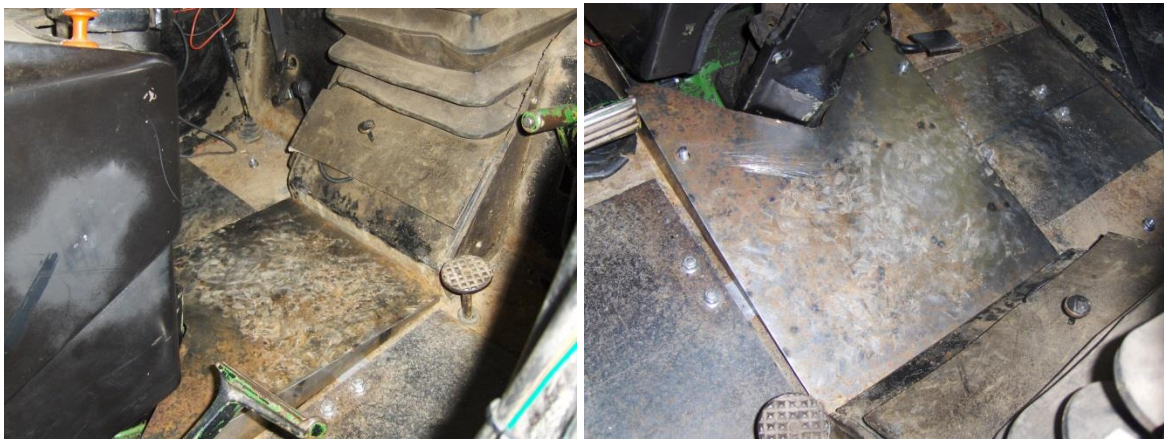
Figur 105: Nytt gulvdeksel montert i traktorhytten, av forfatteren, 2013.
