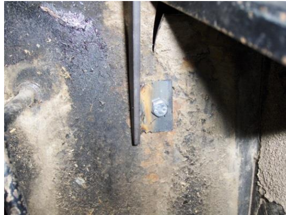
Figur 90: Støttestaginnfestning i gulv, av forfatteren, 2013.
