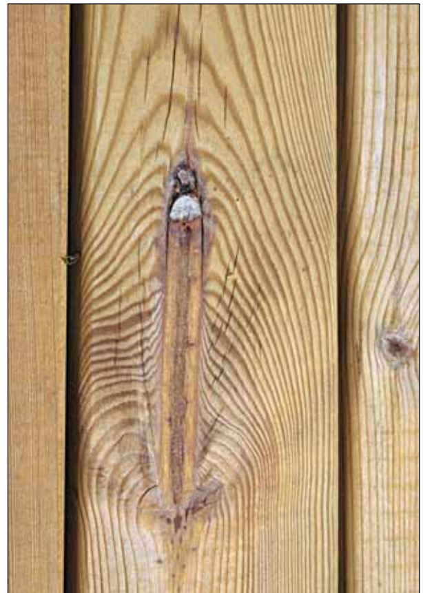
Bilde 36. Selv om stammen brytes av ved toppbeite, kan et sideskudd fortsette veksten og «skjule» skaden.
