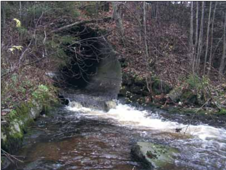
Skansensbekken i kulvert under F84. Ikke noe vandringshinder med slik vassføring.
