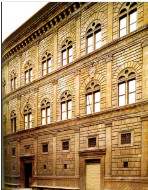
Palazzo Rucellai, Firenze. Foto: Ukjent
