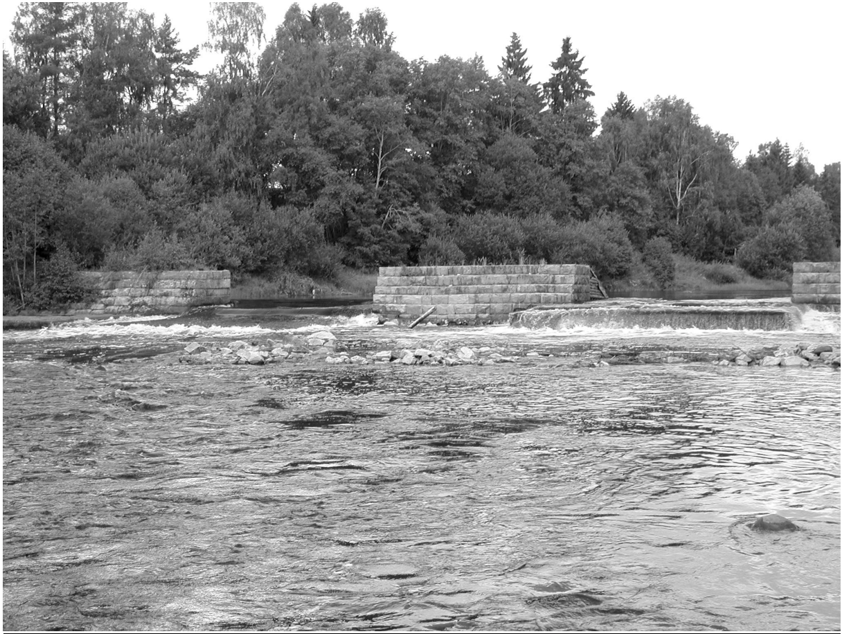
Figur 19: Bildet viser Kjellåsdammen med de to tømmerrennene, der renna til høyre er ombygd til fiskerenne/trapp.
