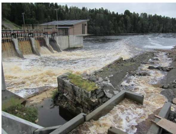
Figur 5. Syversætre Kraftverk ble etablert i 2011. Det er etablert fiskepassasje i tilknytning til kraftverket, usikker virkningsgrad.
