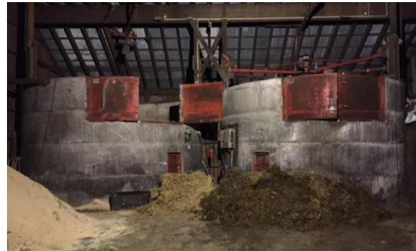
Figur 3 Tårnsiloer i betong bygget inne i en låve. Av forfatteren, 2017.
