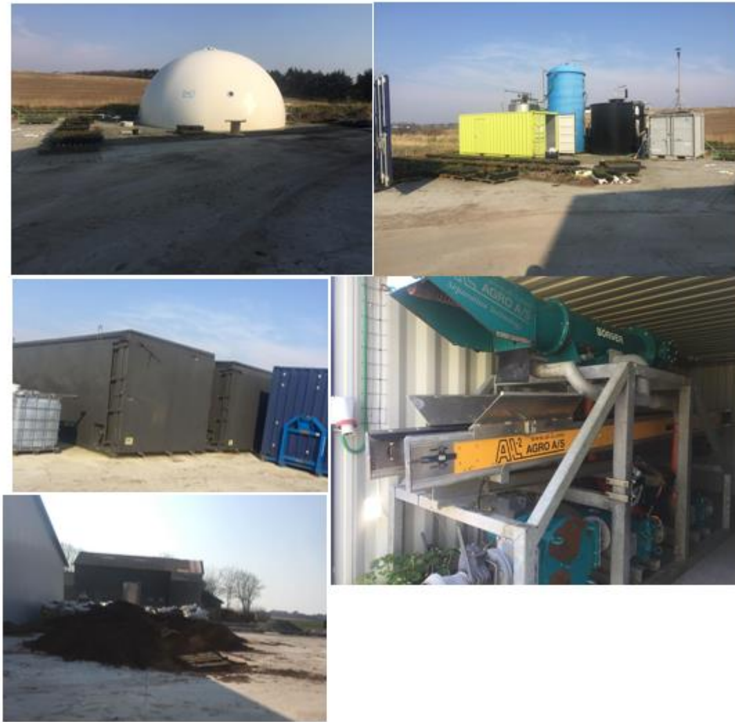
Figur 9. Øverst til venstre: Gasslager. Øverst til høyre: blå og svart tank er reaktorene (telemarksreaktoren er svart), gul teknikkcontainer for styring av pumper m.m, grå container med fyrkjele og fakkell, ståltank i bakgrunnen er en blandetank. I midten til venstre: spesialcontainer for tørr gjødsel. Nederst til venstre: separert kumøkk. Nederst til høyre: mobil seperator.
