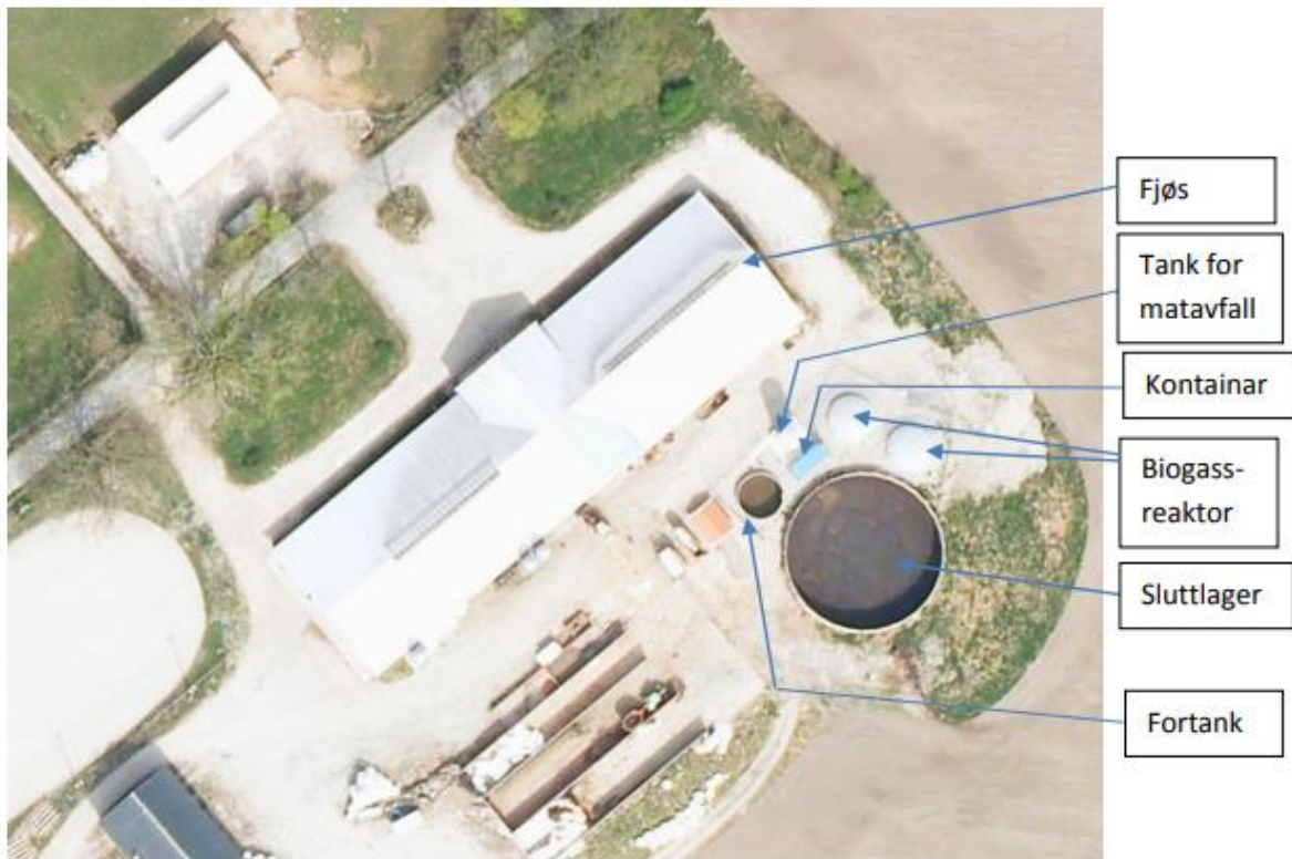
Figur 8. oversiktsbilde over biogassanlegget på Tomb. Foto: (Fjørtoft, Morken & Gjetmundsen, 2014)
