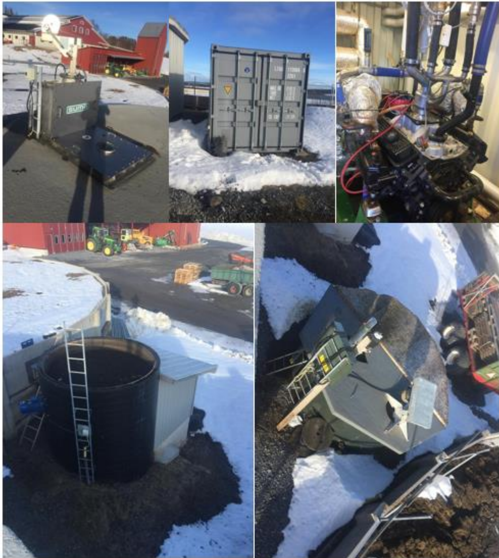
Figur 7. Øverst til venstre: luke til røreverk, når dette åpnes og propellen heises opp vil et spjeld lukkes slik at reaktoren er tett under vedlikehold av propellen. Øverst i midten: container med gasslager. Øverst til høyre: CHP, en ombygd bensinmotor med generator og to effektnivå. Nederst til venstre: tank med rørsløyfe som tar opp noe varme fra det ferdig behandlede substrater. Det er overløp fra denne kummen til sluttkummen ved siden av. Nederst til høyre: Fortank med propell og pumpe som pumper substratet inn i reaktoren. Til høyre for fortanken ser vi en sluttkum nummer to. Alle bilder unntatt de to øverst til høyre er tatt fra toppen av reaktoren. Foto: forfatteren
