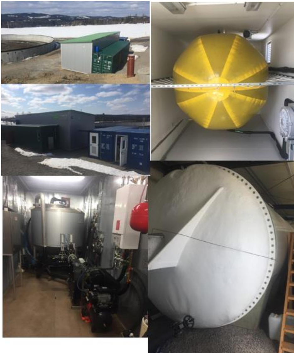
Figur 10. Øverst til vestre: reaktor i grått bygg, forvarmingstank og teknikk i grønn container. Midten til venstre: gasslager og CHP i blå containere. Øverst til høyre: gasslager. Nederst til høyre: biogassreaktor.
