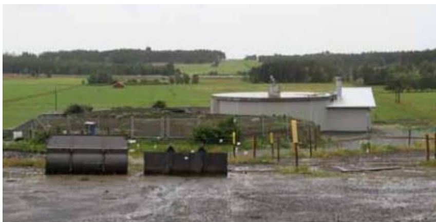
Figur 6. Bilde viser reaktoren med tilbygg som inneholder et teknisk rom og et rom hvor gassen kommer ut av reaktoren og går gjennom en innretning som skyller gassen med vann. Kilde: (Hedegart, 2015)
