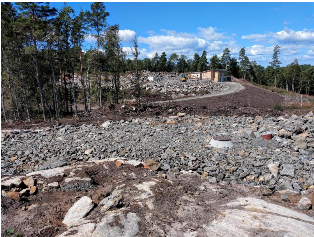
Figur 20: Her er eit døme på korleis ein fritidshusutvikling IKKJE bør gjerast om ein skal sikra langsiktig vekst gjennom påbygging, tilbygg osv. Arealet er flatsprengt, og det leverast ein av seks ferdigfritidshusmodellar som står så tett at det ikkje er rom for seinare utvikling. Illustrasjonen er henta frå utviklinga av det såkalla Alveberget på Tromøy i Arendal kommune - alveberget.no . Foto: Tor Arnesen
