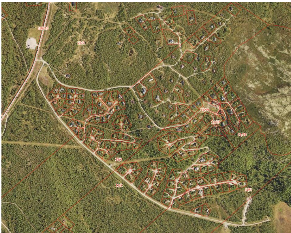
Figur 23: Eit siste døme er henta frå case-kommune Ringebu. Det som pregar utbyggingsmodellen her er mindre intensiv tomtarrondering og låg utnyttingsgrad, ei organisering av tomter som er styrt av den fysiske infrastrukturen, landskapets topologi og hensyn til at funksjonen til fritidsbustadene ikkje er større tilrettelagte service- eller aktivitetsanlegg, men tilgang til tur i lite tilrettelagt terreng. Dette gir rom for eit betydeleg ettermarked i form av byggbetainga investeringar som utløyser over tid. Kjelde for bilede: norgebilder.no
