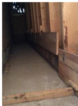
Figur 2 Viser bilde av viftekanal og vifte. Foto: Amund Løken
