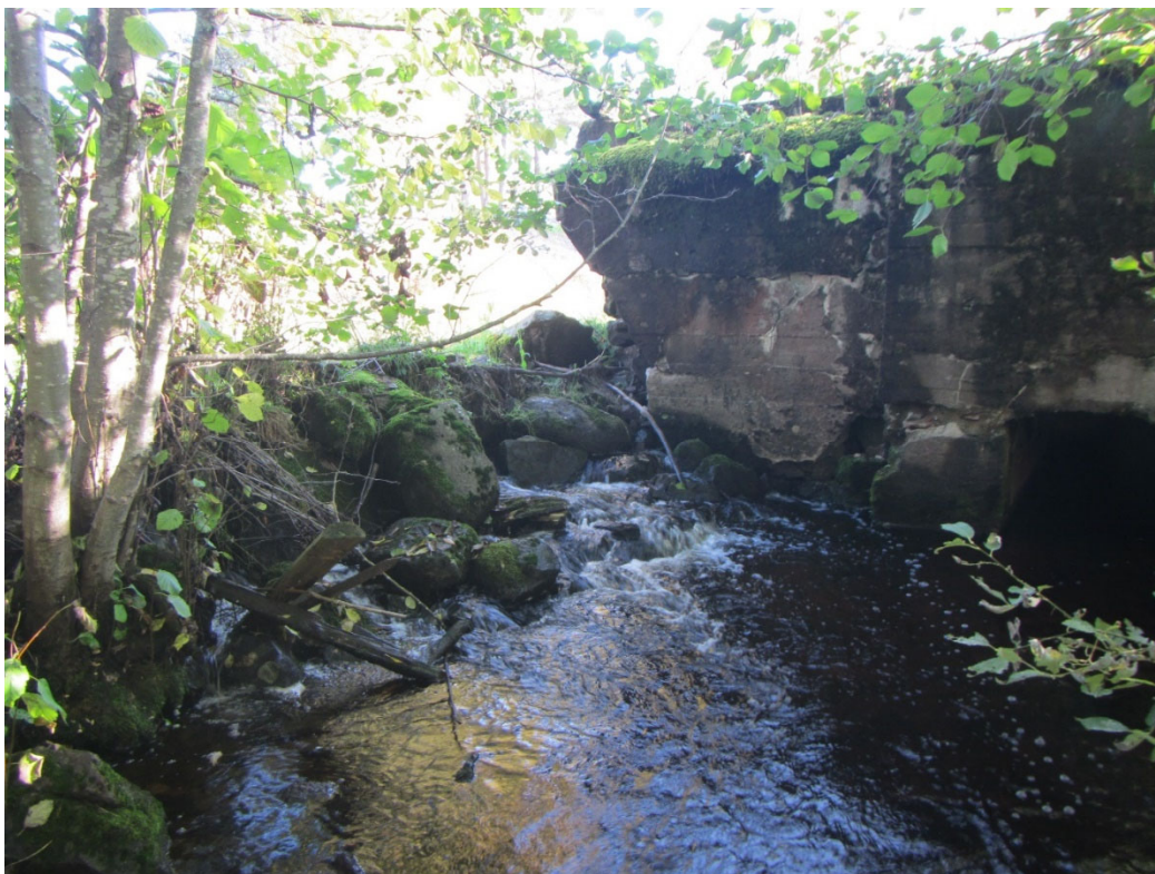
Figur 12. Rester av den gamle mølla og terskelen på nedsiden, terskelen og møllerestene ble vurdert til å være et vandringshinder for videre oppvandring.
