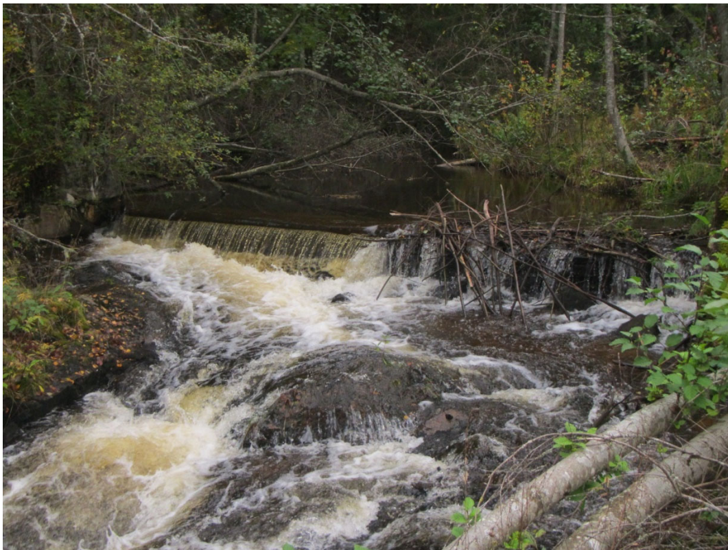
Figur 5. Betongterskelen som er anlagt i elva. Terskelen vurderes til å være en sperre for videre oppvandring i vassdraget.
