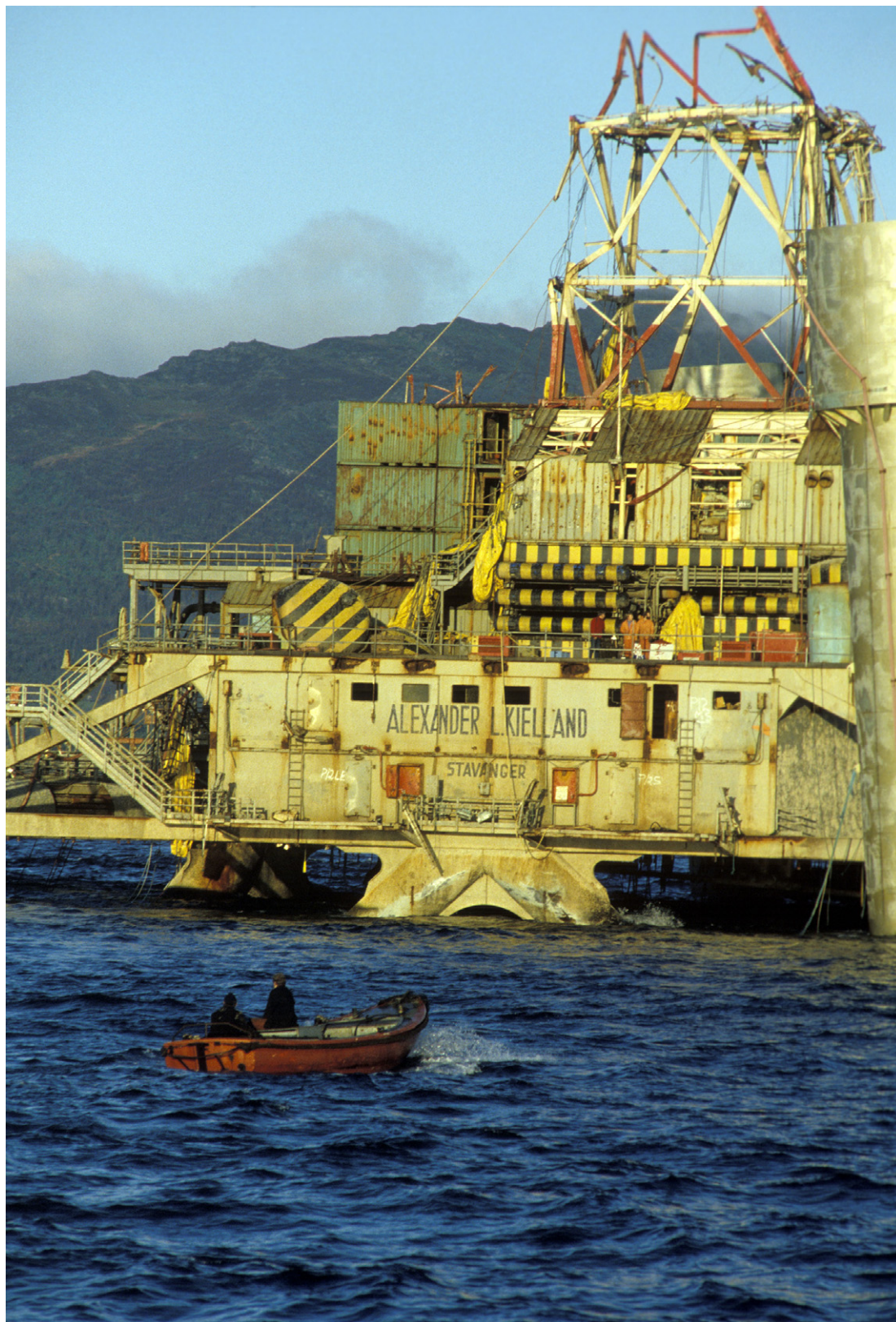
Fra forsøkene på sning av plattformen. Plattformen ble senket med 50kg sprengstoff, og sank på 712m dyp i Nedstrandsfjorden, nord for Stavanger. To tidligere snuoperasjoner var mislykket. Foto: Bjørn Sigurdsøn / NTB
