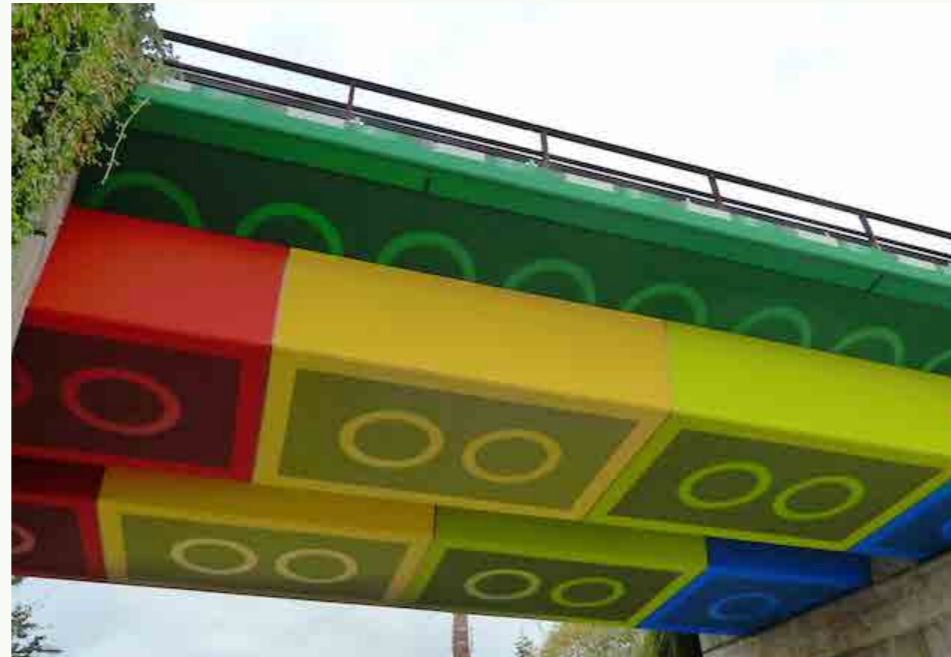
Undersiden av en bro trenger ikke å være kjedelig Ukjent
