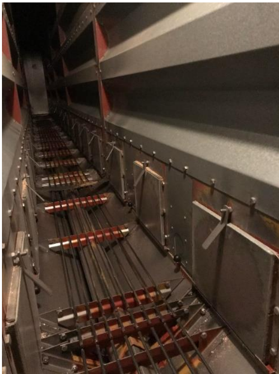
Figur 10: Viser innvendig i hovedluftkanalen med flyttbare luker til luftkanaler. Foto: Lars Jakob Veflingstad, 2022.
