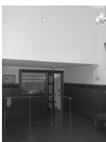
III 9.21-23: Billettluken sett fra vestibylen, med nedsenket tak som gir plass til maskinrommet.
