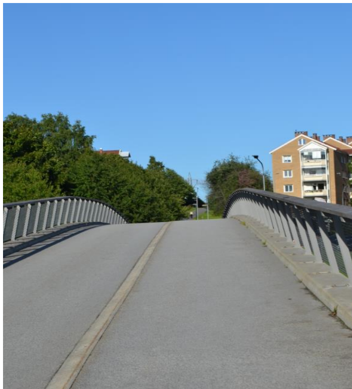
Figur 9: Bro ved Hovinveien.
