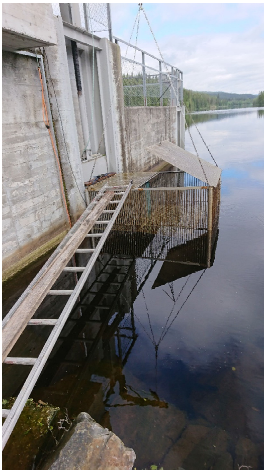
Figur 4: Fiskefella i Storsjødammen i hevet (t.v.) og neddykket tilstand (t.h.).
