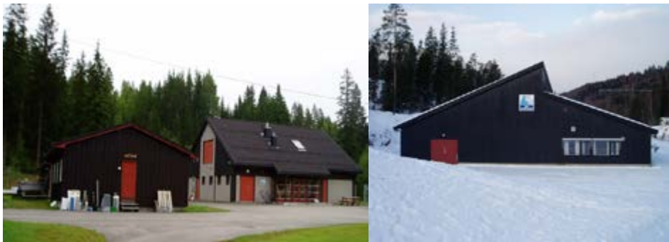
Evenstad settefiskanlegg, oppført 1984-88 (t.v) og GLB Evenstad settefiskanlegg, oppført 1992, GLB Løpet settefiskanlegg på Rena, oppført 1993. Foto: Evenstad Kultiveringsanlegg
