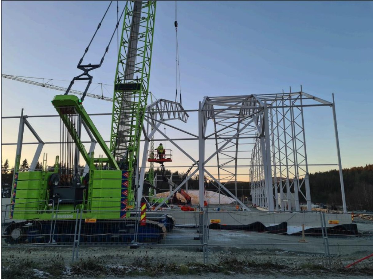
Figur 6: Elektriske maskiner på byggeplass (Hentet fra Power Point presentasjon av byggeprosjektet).
